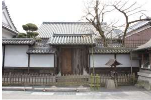
旧矢掛本陣石井家住宅 御成門
