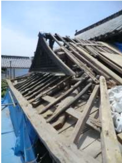
福武家住宅主屋保存修理工事（三谷）
