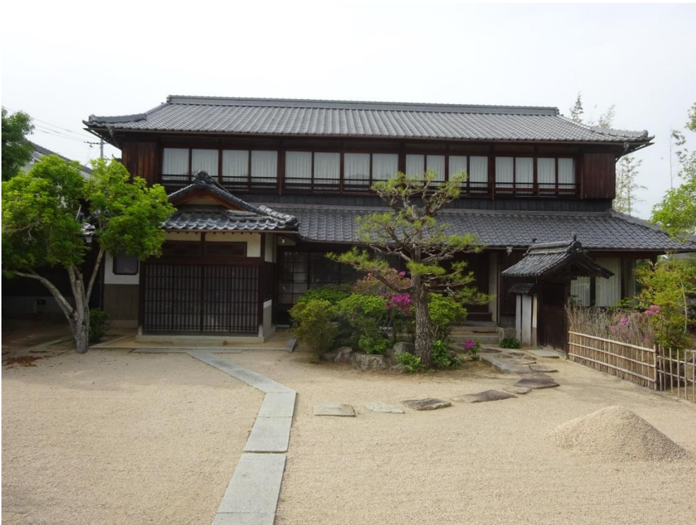
外観(母屋)約90坪(1階55坪, 2階35坪)
