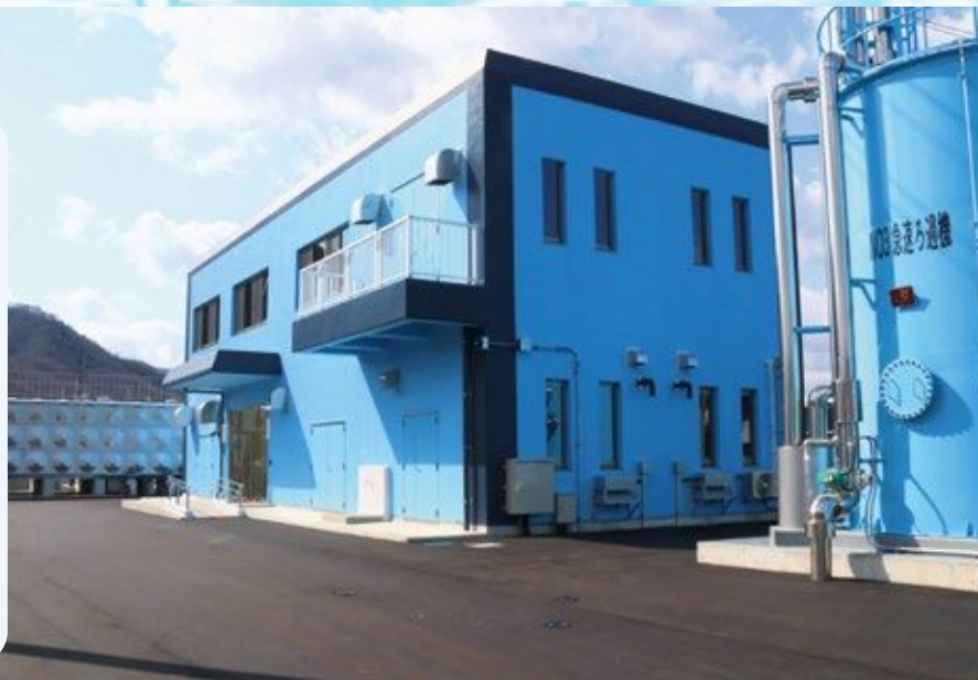
↑ 完成した東川面浄水場
