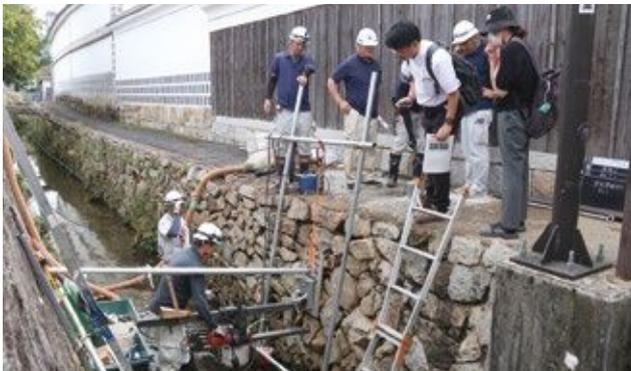
↑ 石積護岸を耐震補強する試験施工の現場
