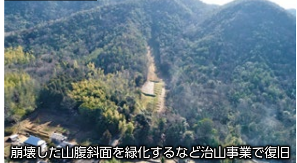
災害復旧工事後
