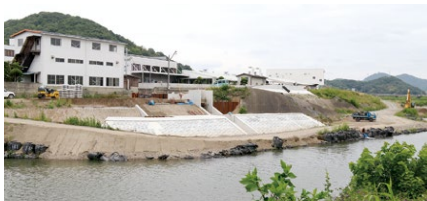
↑ 現在、工事中小田川堤防護岸強化工事（小田地内）
