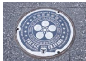
新しく設置した デザインマンホール
