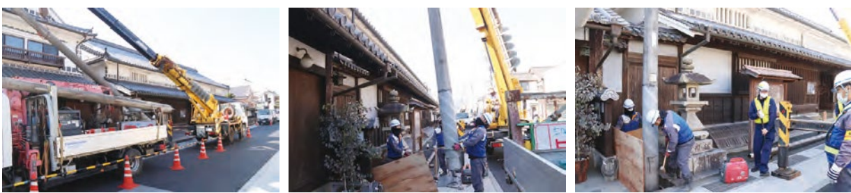
本陣前の電柱撤去の様子
