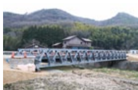
【内田地内古屋谷橋】
