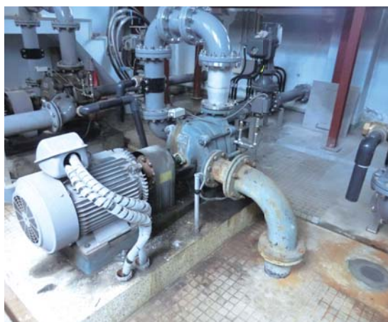
東川面浄水場 送水ポンプ 昭和48年設置
