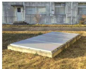
東川面水源地(3)
