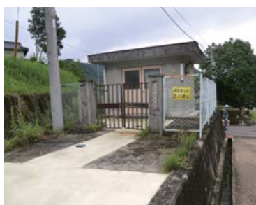
日置谷加圧ポンプ場
