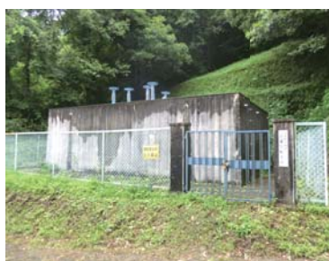
日置谷配水池
