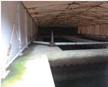
東川面浄水場 沈澱池
