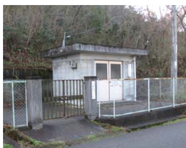
大唐田加圧ポンプ場
