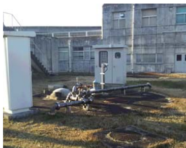
東川面水源地(1)
