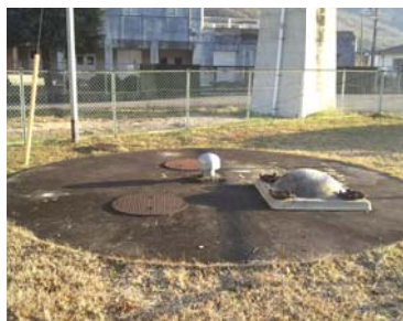
東川面水源地(2)
