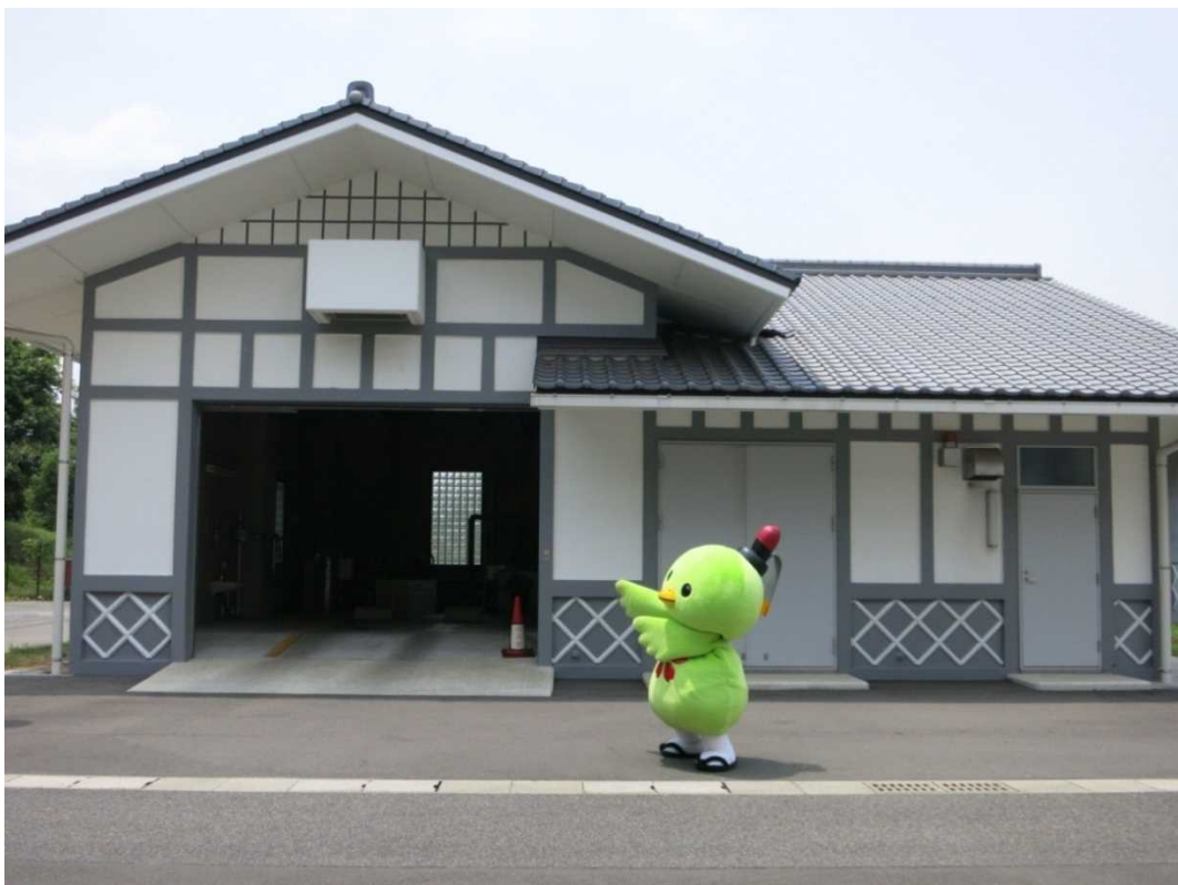
矢掛浄化センター内 M I C S 処理施設
