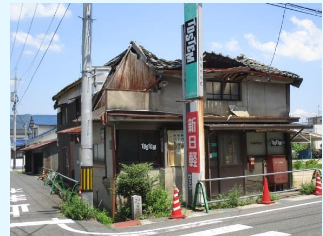
写真：例 利活用不可 （除却候補）物件
