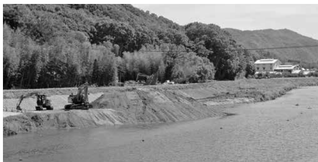
着々と雑木伐採と浚せつ工事が進められている小田川
