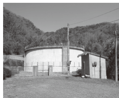
高妻山の配水池
