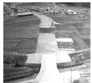
建設途中の町道運動公園線
