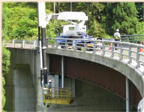
橋梁点検車による点検
