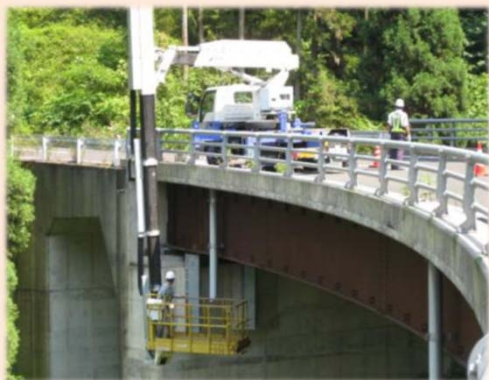
橋梁点検車による点検
