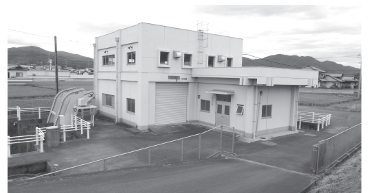
内水氾濫への対処…排水設備の拡充を！ （中川地区江良：福万地区排水機場）
