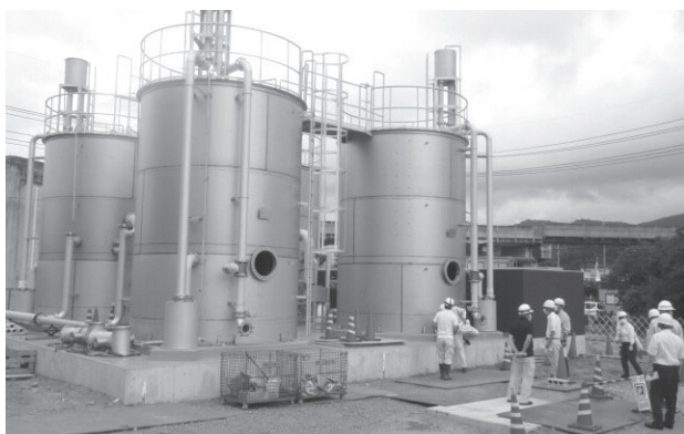
新設の東川面浄水場の巨大なタンク
