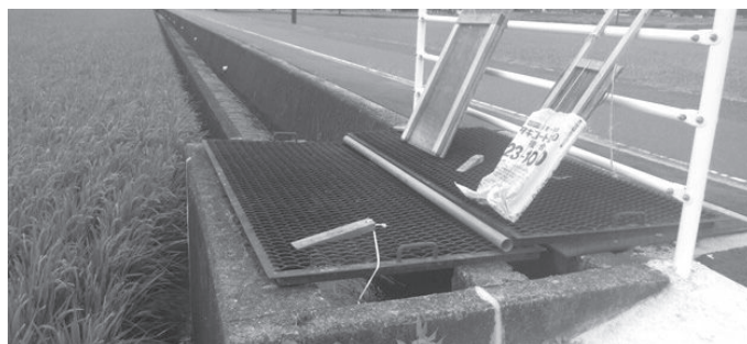
農業用水マスの改良
