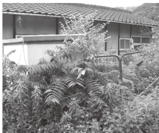
空き家の敷地内に雑草が繁茂している状況
