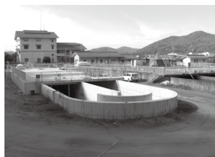
活性汚泥処理槽(オキシデーションディッチ)
