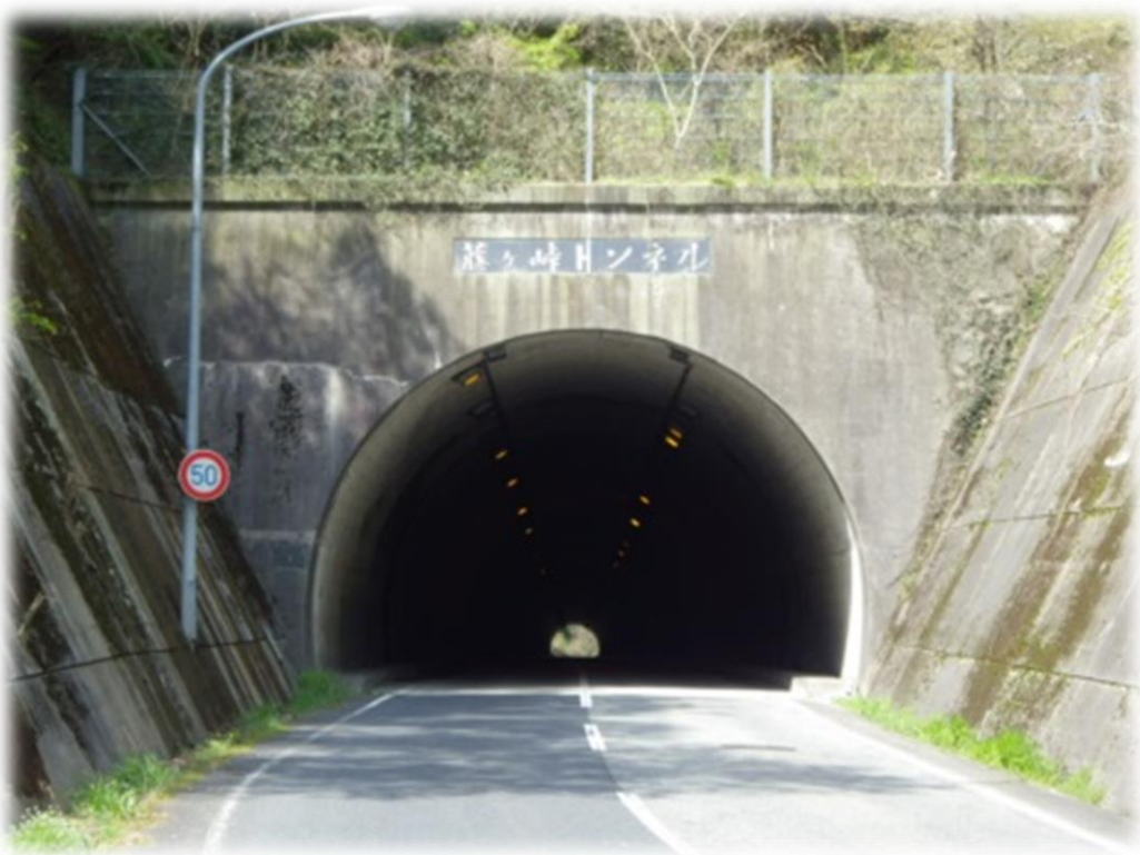
藤ヶ峠トンネル
