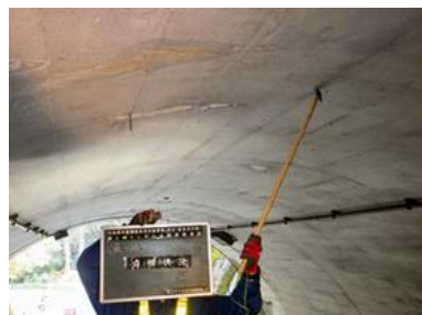
打音検査および叩き落とし
