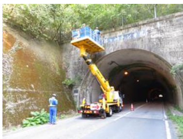
近接目視点検
