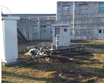
東川面水源地(1)
