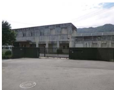
東川面浄水場 正面入口
