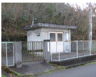
大唐田加圧ポンプ場
