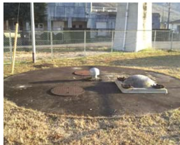
東川面水源地(2)
