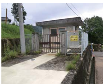
日置谷加圧ポンプ場
