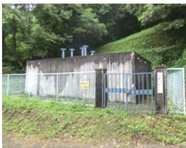
日置谷配水池
