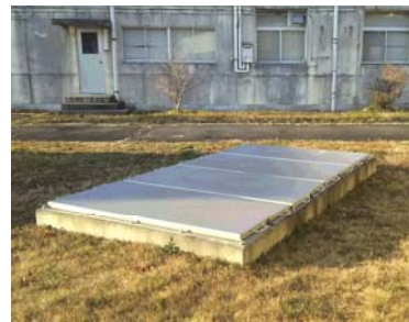
東川面水源地(3)
