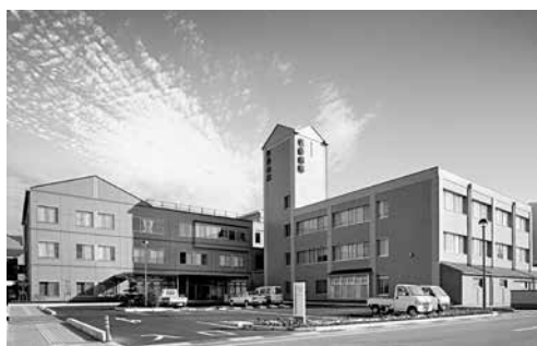
矢掛病院(外観)
