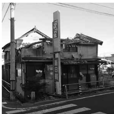
◎横断歩道を含む道路近辺はまさに子どもたちが通るスクールゾーン。建屋撤去で通行するすべての町民の安全を守る予算措置を承認する！
