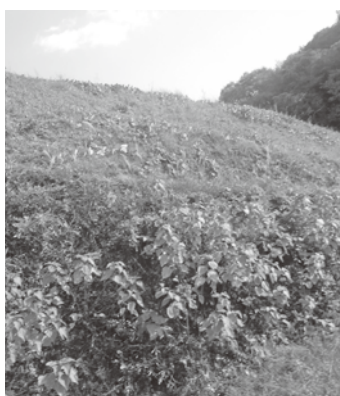
災害時の危険が心配されるため池
