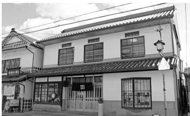
「まちの駅」としての機能を有するやかげ町家交流館
