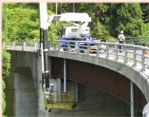
橋梁点検車による点検
