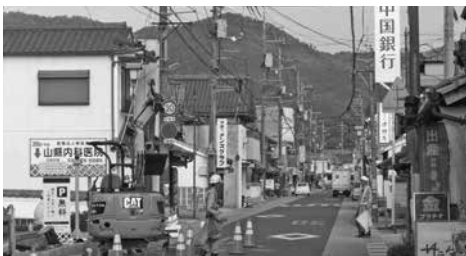
無電柱化工事が着手となりました
