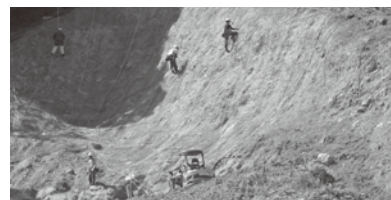
横谷 大渡地区 災害復旧工事の様子
