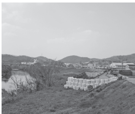
改修中の小田川左岸堤防(中川地区) 後方は中川小学校、左奥は中央橋
