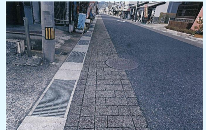
写真：路線両側のハンプ及び排水側溝
