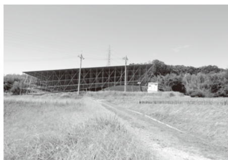
高さをとってある太陽光発電システム
