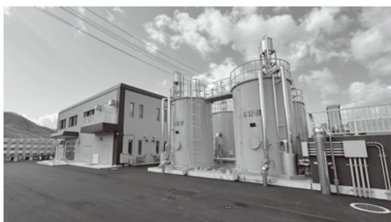
新設した東川面浄水場
