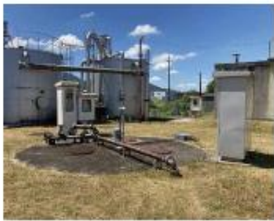
東川面水源地(1)
