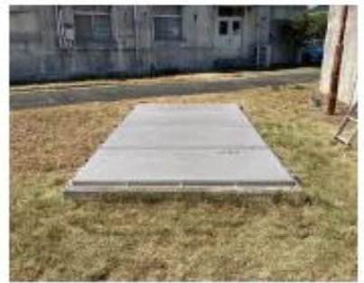
東川面水源地(3)
