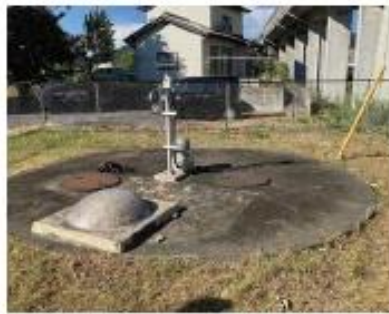
東川面水源地(2)
