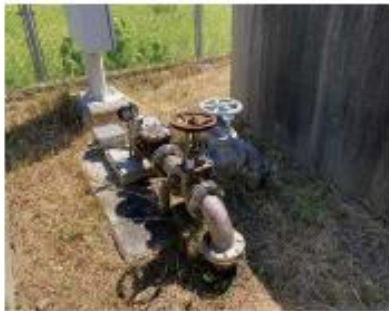
東川面水源地(4)
