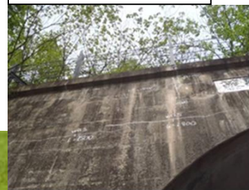
水平方向ひび割れ（終点側）
