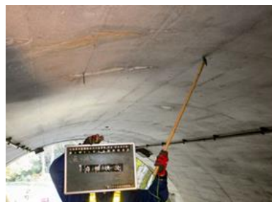
打音検査および叩き落とし
