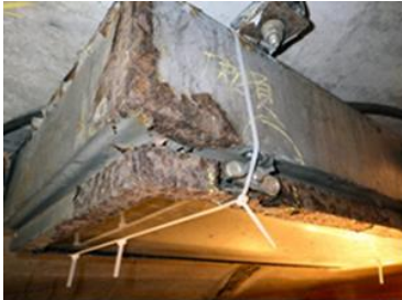
照明器具の腐食（平成30年度点検）
