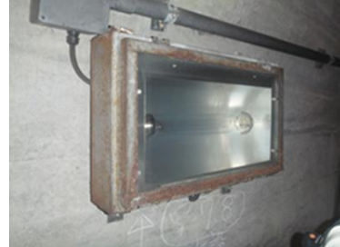
照明器具の腐食（平成25年度点検）
