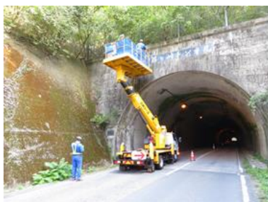
近接目視点検
