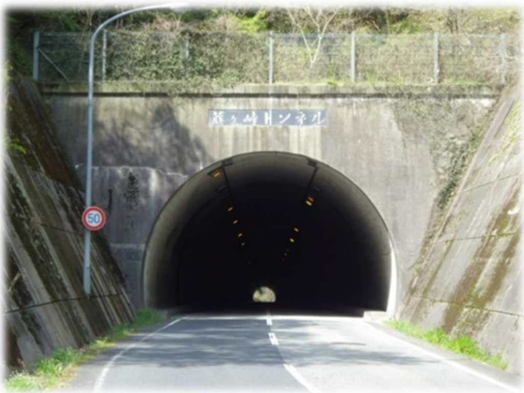
藤ヶ峠トンネル
