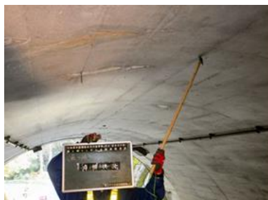
打音検査および叩き落とし
